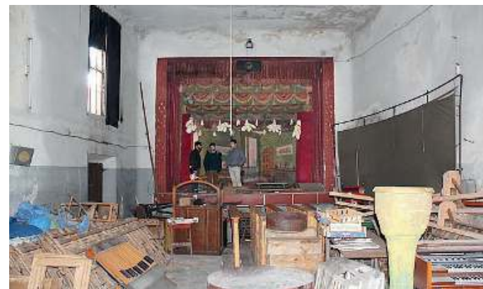
All'interno. La struttura fu trasformata in un magazzino
