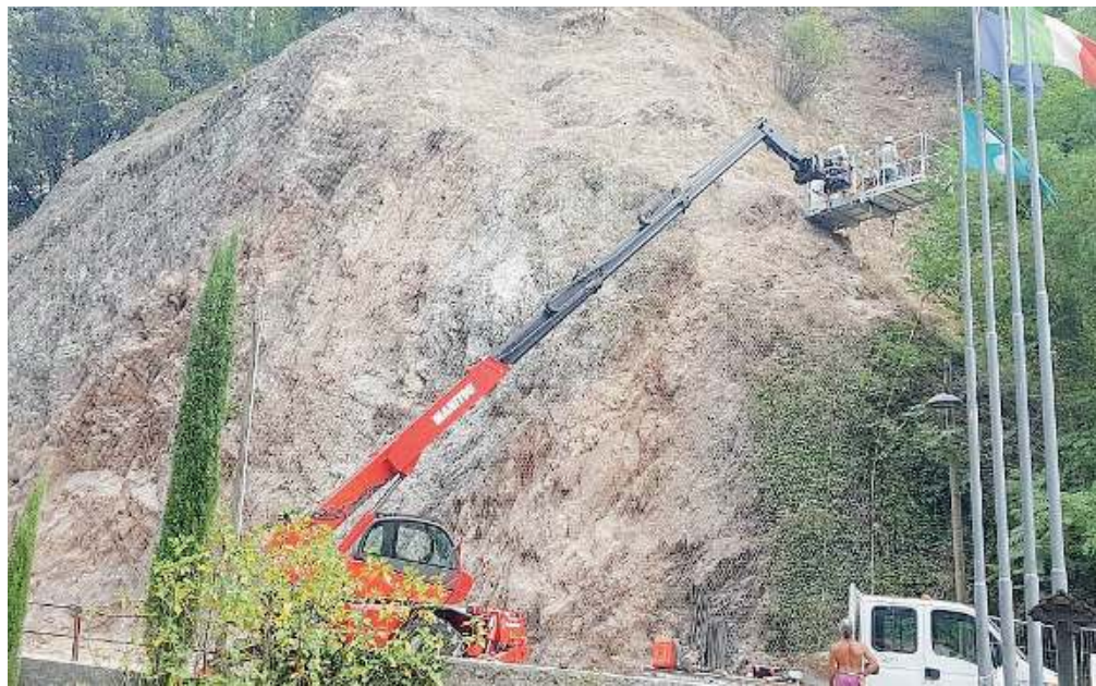
Lavori in corso. La parete rocciosa sarà messa in sicurezza dopo i crolli del 7 agosto
