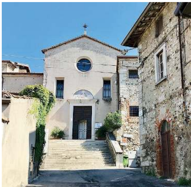
Durante l'estate. Senza sosta i lavori di ristrutturazione
