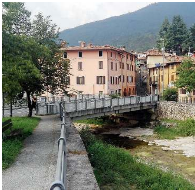
Sul Vrenda. Il ponte è stato costruito negli anni Novanta
