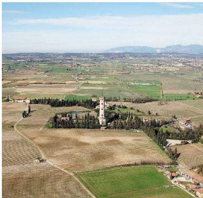
Una veduta di San Martino. Il progetto di sicurezza inizia dalla frazione
