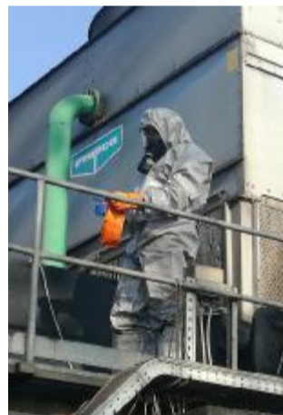
Ultimate le opere di sanificazione
