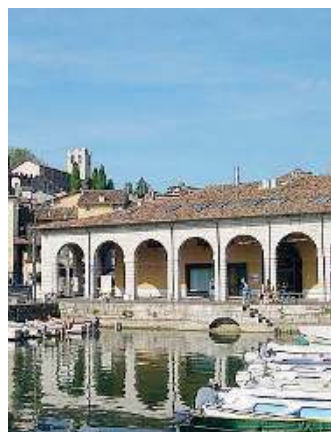
Lavori. Palazzo Todeschini
