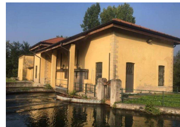
La centrale idroelettrica di Muscoline torna sotto i riflettori
