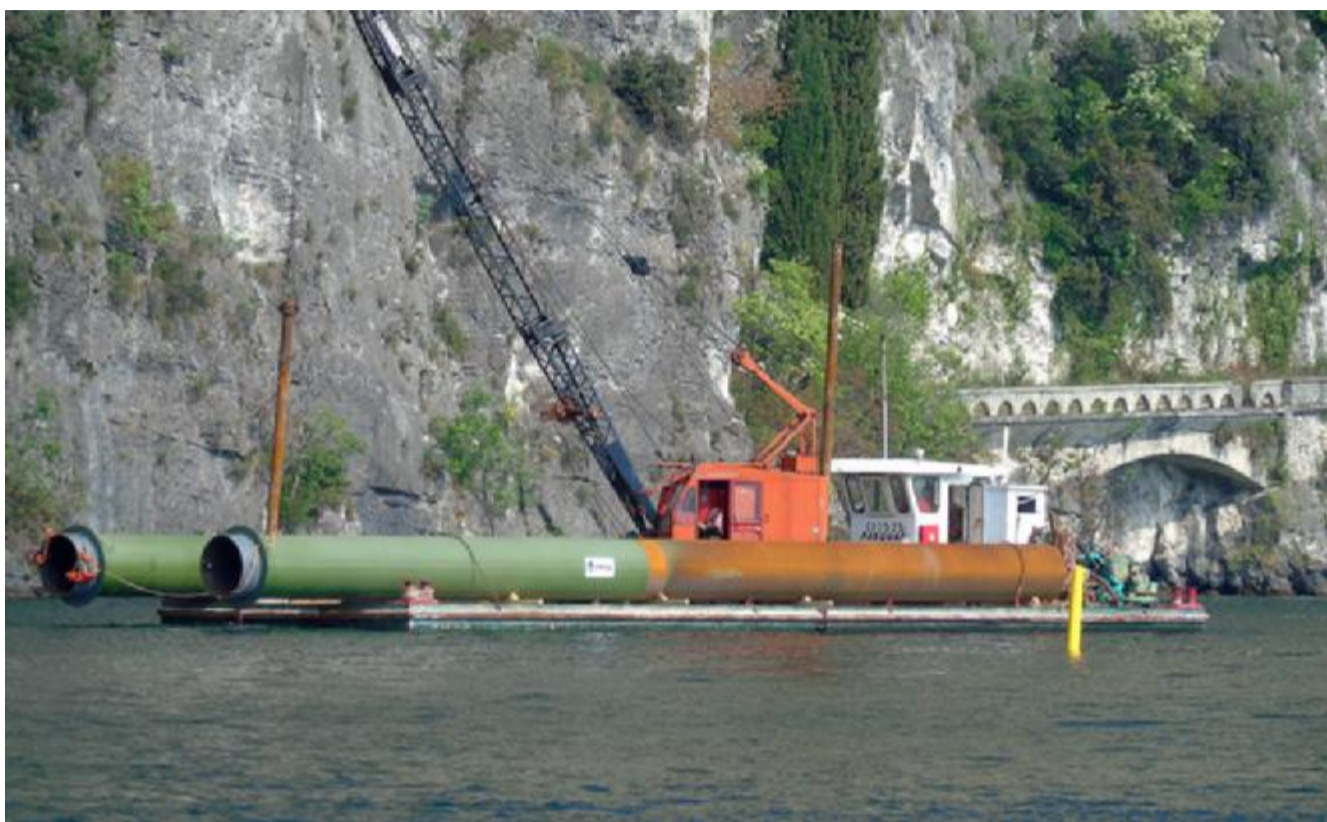
Una fase dei lavori preparatori per la posa della gigantesca diga mobile davanti a Univela a Campione: sarà lunga 80 metri lineari
