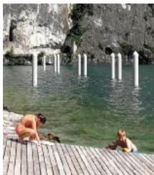
I pali sono già infissi sul fondale
