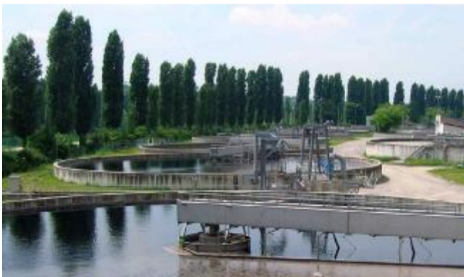
Il depuratore di Peschiera, l'unico grande impianto esistente sul Garda
