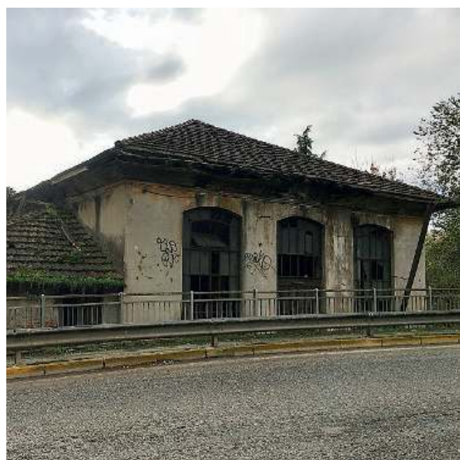
Da recuperare. L'ex centralina idroelettrica del Bettoletto
