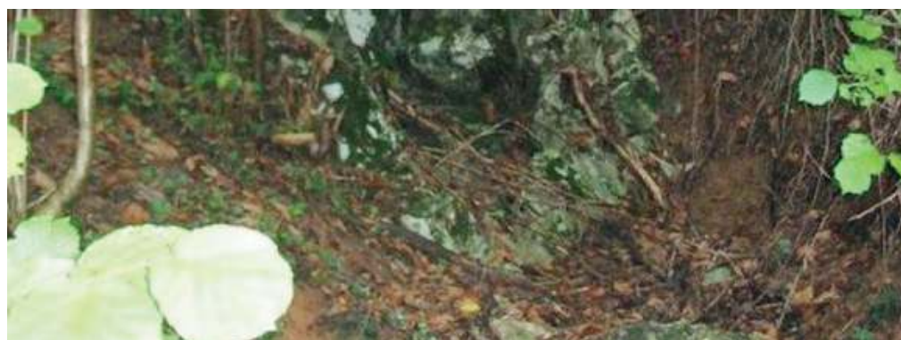
Interventi urgenti. Uno scorcio dell'alveo del rio dei Cugni
