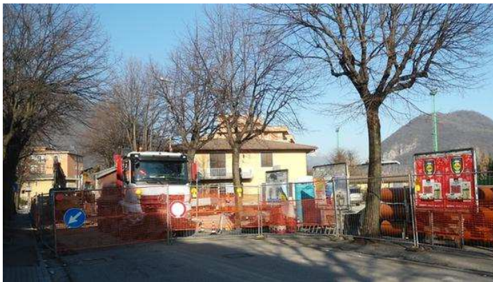
Interruzioni stradali a Gavardo per la posa del collettore
